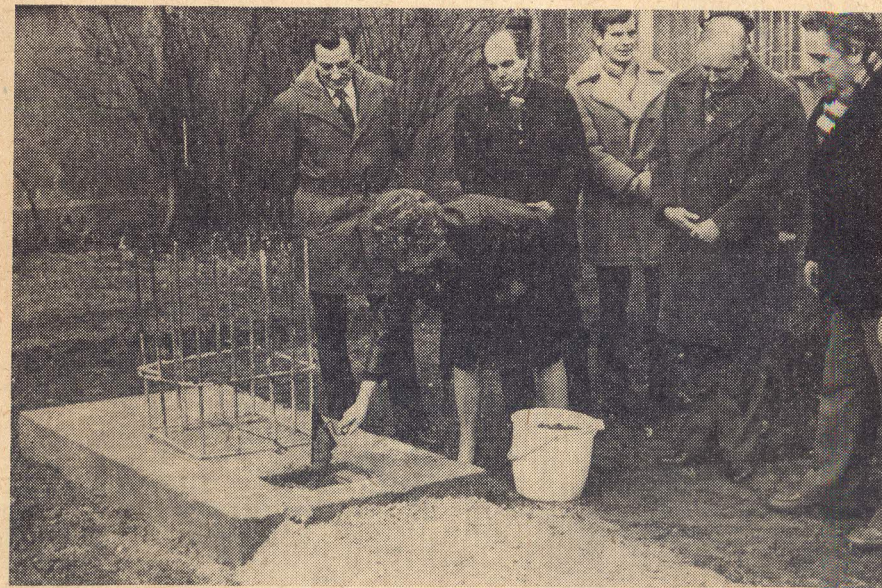
16 grudnia 1982 r. — Wmurowanie aktu erekcyjnego w fundament pomnika G. Narutowicza
